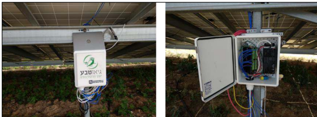
תמונה 12 קופסאות אוגרי הנתונים המודולים והמודם הסלולרי
